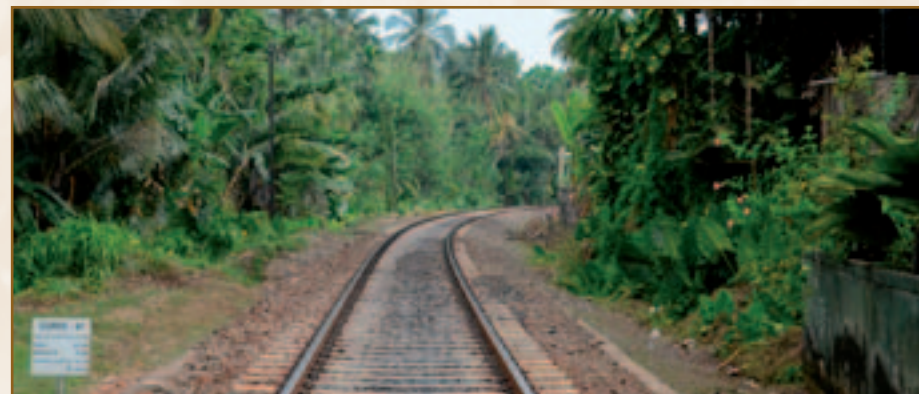
Oblúky sú označené číslom, polomerom a kilometrickou polohou.
